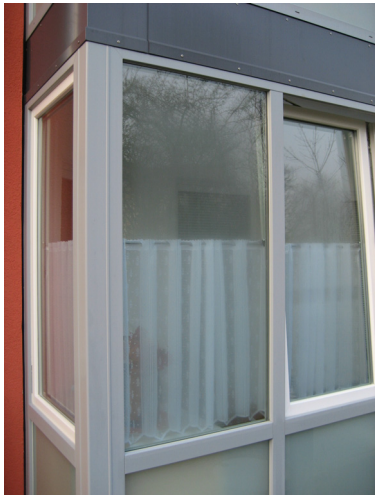
Abbildung 2: Verglaste Schallschutzloggia; Fenster mit umlaufenden Dichtlippen
